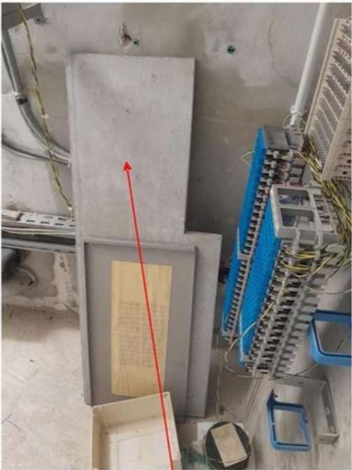
S1: plaque de fibro ciment posée contre le mur
